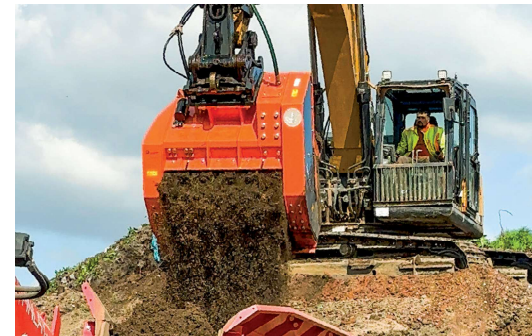
RIS setzt bei der Aufbereitung schwieriger, bindiger Baustellenerden auf den Schaufelseparator Terra-Star TSP.124, der die stationären Siebanlagen entlastet und den Oberbodenertrag um bis zu 25 % steigert. Quelle: Kronenberger Oecotec
