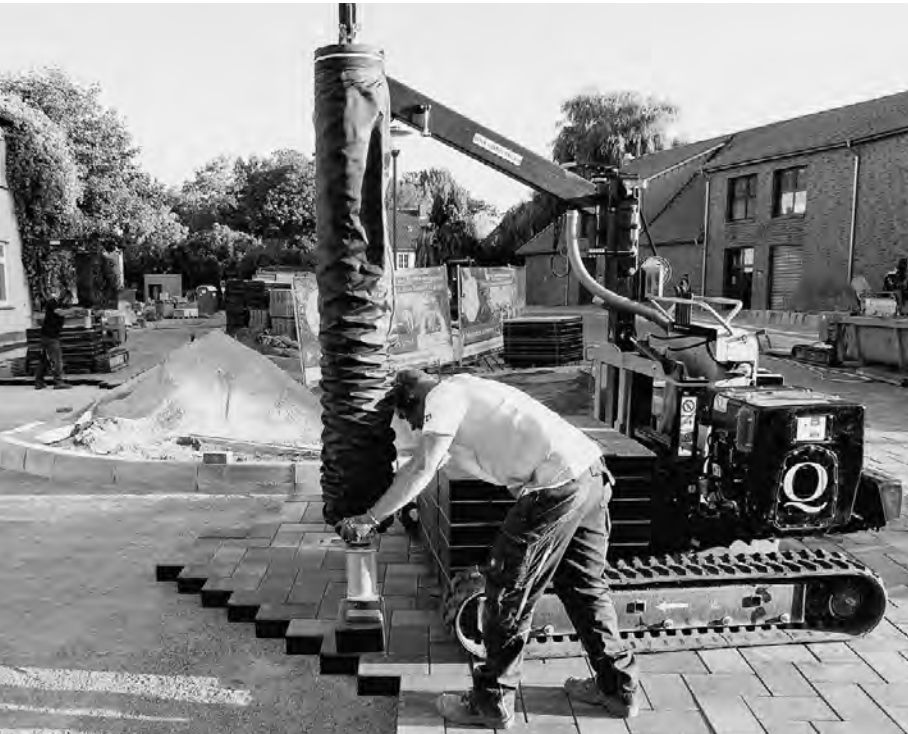
Bei der Sanierung des Urgeschichtlichen Zentrums Wildeshausen (UZW) sind zeitweise drei Optimas-Vacu-Pallet-Mobile im Einsatz.
