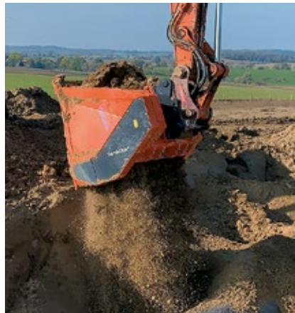
verfüllen siebt der Bagger mit dem Schaufelseparator direkt in den Rohrleitungsgraben und zerkleinert beim Absieben die Erdkugeln. Hohes Einsparpotential bietet der Terra-Star auch im Kanalbau: Anstatt Aushubmassen auszutauschen und zu deponieren, kann man sie zur Wiederverwendung recyceln. Die Bodenverbesserung wiederum erfolgt durch Zugabe von Kalk oder Kalkmischbindern. So kann man bindige Aushubmassen kostengünstig zu tragfähigem Unterbaumaterial aufbereiten. Das Material kann dann
