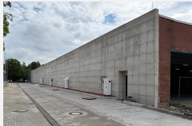
Errichtung der Brandschutzwand an der Bushalle für E-Mobilität (Ladesäulen für E-Busse)
