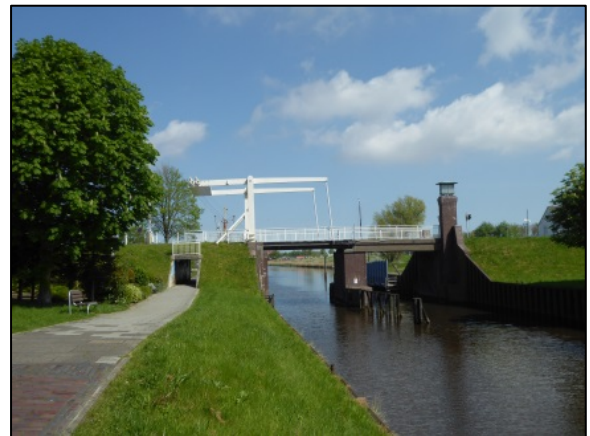
Brücke Friedrichsschleuse (von Süden) mit Weg/Promenade auf der Westseite
