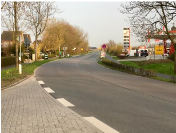
Hauptstraße am südlichen Ortseingang
