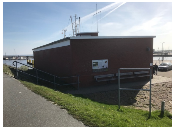
Rettungsbootschuppen, von Südwesten
