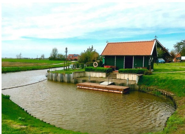
Anleger/Bootshaus in Altharlingersiel
