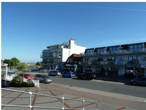
Ortskern Bensorsiel, südlich des Hafens
