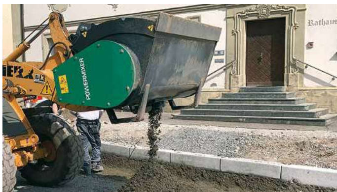
Der Powermixer wird mit angeschweißtem Radladeradapter geliefert. Mit den optional lieferbaren Wechseladaptern ist er flexibel einsetzbar.
