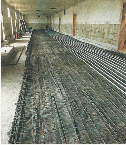
△ Aichele hat Boden, Wände und Decken im ehemaligen Sauenstall erneuert. Den planbefestigten Boden der Liegefläche kann er mit Heizschlangen wärmen (linkes Foto). Der Laufgang ist erhöht. Die gefliesten Wände hat er mit Kunststoffplatten überklebt (rechtes Foto).
