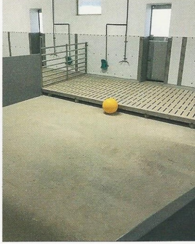
△ Aichele hat Boden, Wände und Decken im ehemaligen Sauenstall erneuert. Den planbefestigten Boden der Liegefläche kann er mit Heizschlangen wärmen (linkes Foto). Der Laufgang ist erhöht. Die gefliesten Wände hat er mit Kunststoffplatten überklebt (rechtes Foto).
